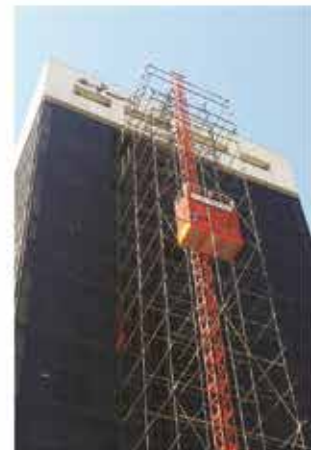
آسانسور ویژه حمل بار و تجهیزات صنعتی یا ایمنی کامل جهت احداث ساختمان های مرتفع، صنایع دریایی، برج های نیروگاهی و سد سازی
