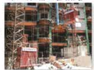
آسانسور ویژه حمل بار و تجهیزات صنعتی یا ایمنی کامل جهت احداث ساختمان های مرتفع، صنایع دریایی، برج های نیروگاهی و سد سازی
